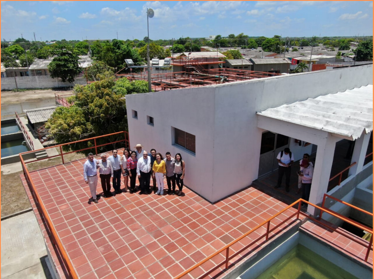
Planta de potabilización El Tesoro, Malambo
