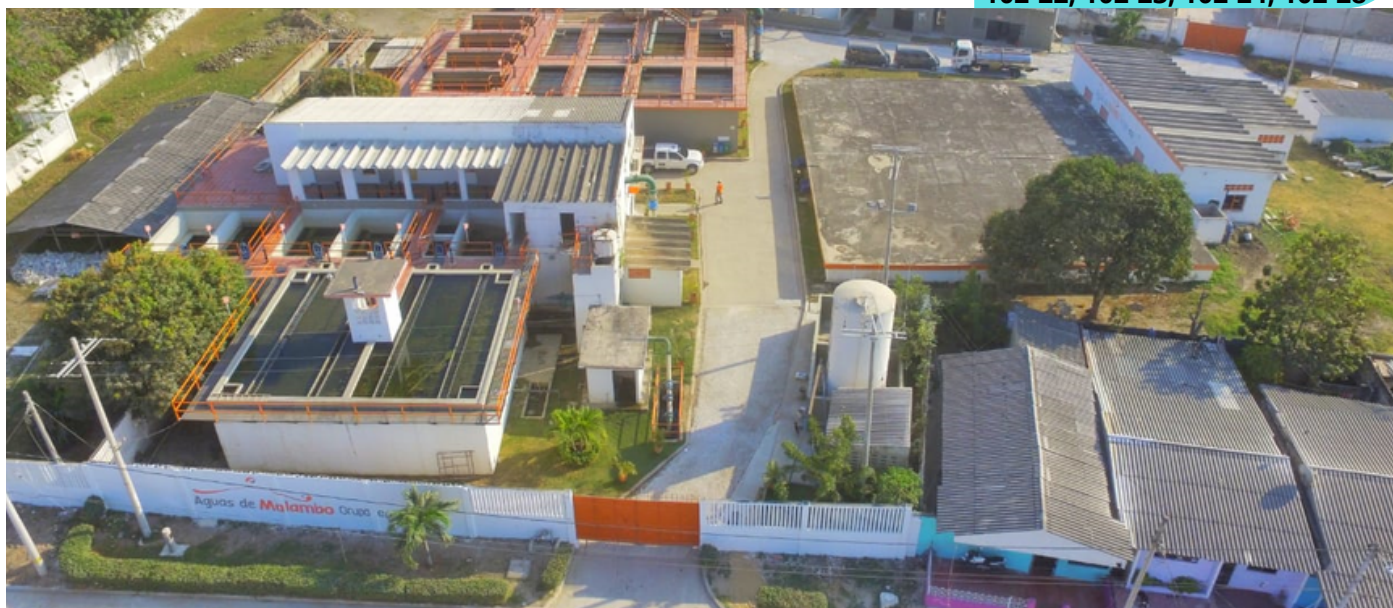
Planta de potabilización de agua potable El Tesoro, Malambo
