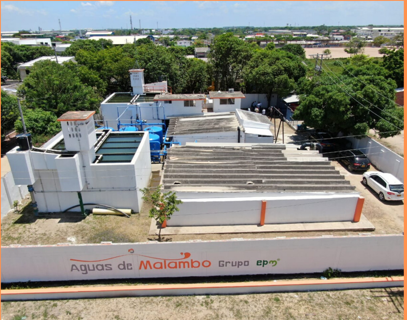
Planta de potabilización de agua Concord, Malambo
