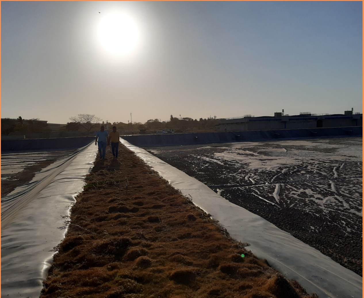
Planta de Tratamiento de aguas residuales, Malambo (En construcción)
