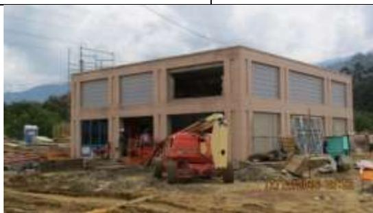
**Subestación principal (SE) :(Prog.96,7%, Ejec.94,7).** La Estructura se encuentra terminada y con los equipos instalados, entre las actividades del período se realizó la planeación de la ejecución de las pruebas.
