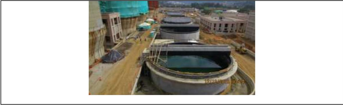
**Edificio de espesamiento y deshidratación** la estructura se encuentra terminada, se encuentran montadas las centrifugas empesadoras y deshidratadoras y el sistema de dosificación de polímeros.
