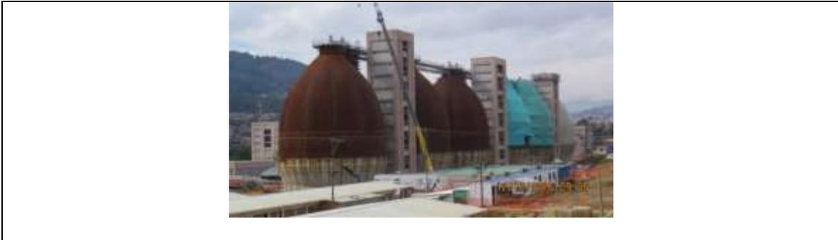
**Torres de abastecimiento de digestores: (Prog. 74,6%, Ejec.67,4%)** las estructuras de concreto se encuentran terminadas, en el período se desarrollaron actividades de mampostería y acabados arquitectónicos y la instalación del apantallamiento eléctrico.
