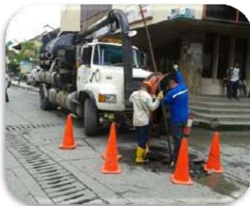
Mantenimiento con el equipo de succión presión
