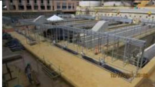
**Estructura de distribución sedimentación primaria (DP) :(Prog. 75,4%, Ejec. 75,3%).** La estructura de concreto se encuentra terminada, se avanzó en la construcción del filtro y lleno estructural en todo el perímetro de la estructura, se realizan reparaciones de concreto al interior de la estructura y se avanza en los trabajos de montajes mecánicos.
