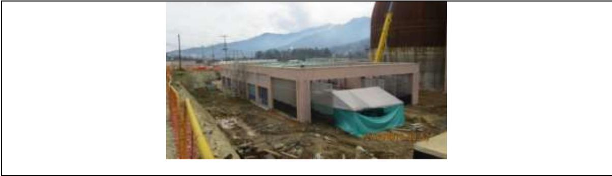
**Obras civiles tanque agua de servicio y contra incendios (TI): (Prog. 96,0%, Ejec. 96,6%)** la estructura de encuentra terminada con las pruebas de estanqueidad de la primera etapa.
