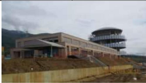
**Edificio de mantenimiento (EM): (Prog.76,4%, Ejec.74,9%).** La estructura se encuentra terminada, con el puente grúa instalado.
