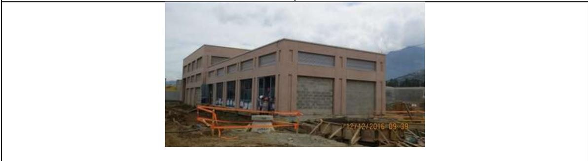
**Desarenadores (AD): (Prog. 92,3%, Ejec. 92,4%).** La estructura de concreto se encuentra terminada, se avanzó en el montaje de los puentes rascadores de arenas, las bombas y los sopladores, en cuanto al sistema eléctrico se avanzó hasta el 70% de las bandejas portacables.
