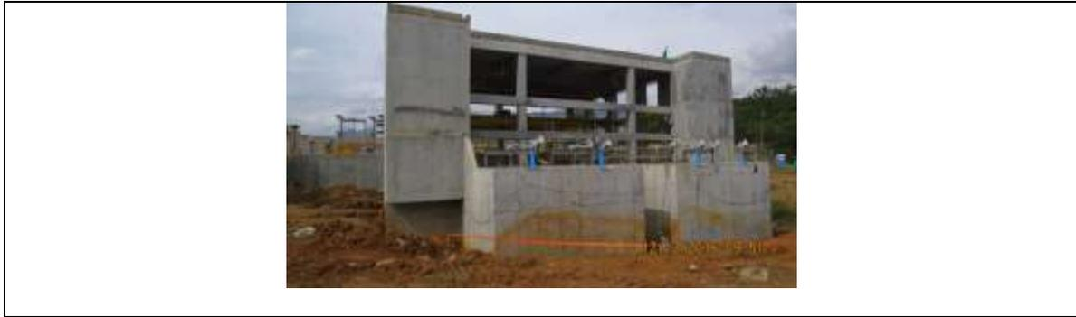
**Canal de descarga (CS): (Prog. 95,7%, Ejec.99, 4%).** La estructura de concreto se encuentra terminada, durante el período se ejecutaron actividades de llenos estructurales se inició la instalación de la canaleta Parshall en fibra de vidrio.
