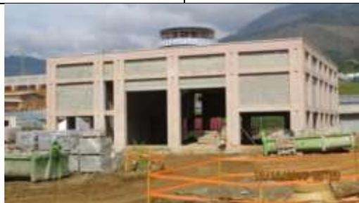
**Edificio para lavado de vehículos biosólidos (EL): (Prog. 79%, Ejec. 66,7%).** La estructura de Este edificio se encuentra terminado, en el periodo se ejecutaron actividades de instalación de banco de ductos, instalación de puente grúa, mampostería exterior en ladrillo coral e instalación de red contraincendios.
