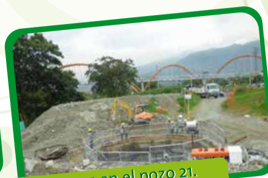
Avances en el pozo 21. Av. Regional frente al coliseo Tulio Ospina, Bello.
