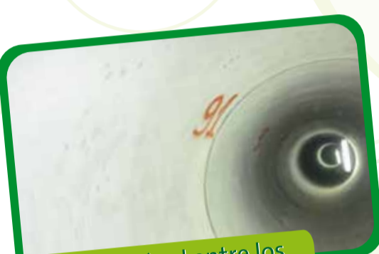
Tramo del túnel entre los pozos 2 y 3 terminado. Sector La Herradura
