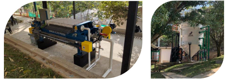
Construcción de sistema de tratamiento de lodos en Sopetrán.
