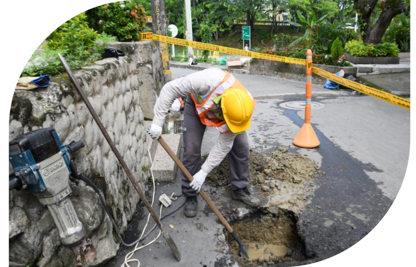
Ilustración: arreglo fuga, Occidente
