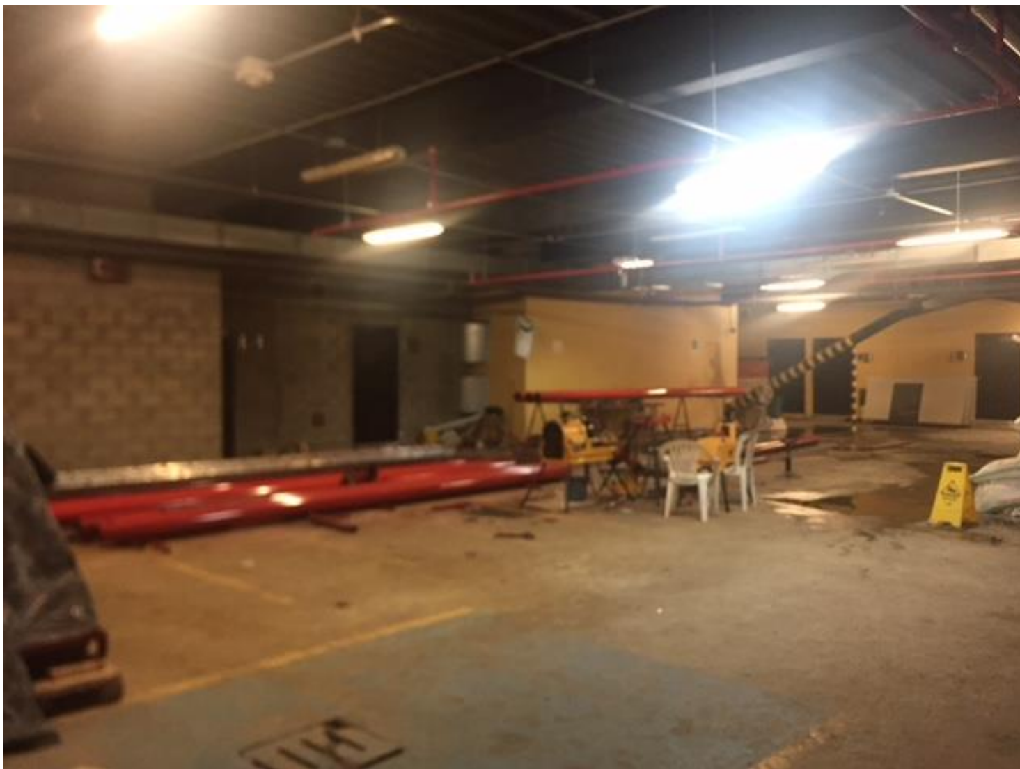
Localización del tanque.
