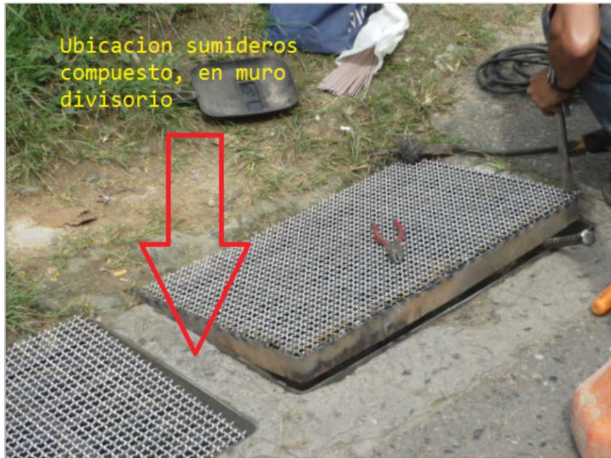
Ilustración 1. Toma dato ubicación sumideros compuesto.
