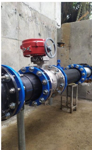
Foto 5 y 6, macro instalado para medir caudal de entrada a la planta, macro instalado para medición de caudal en bocatoma.
