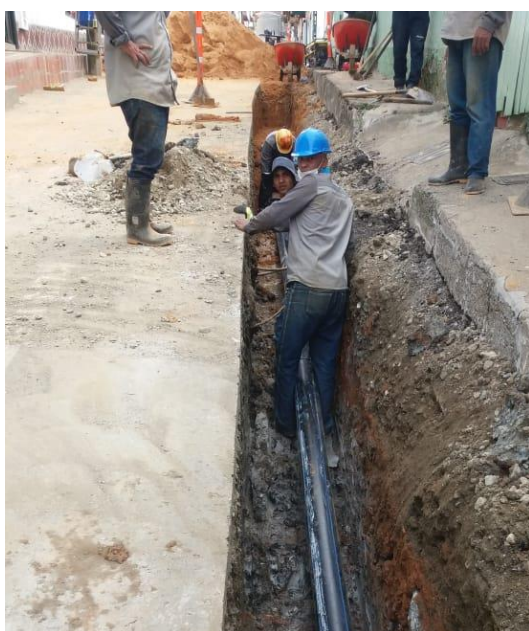
Fotos 9 y 10 instalación de tubería PEAD 160 mm.
