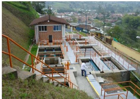
La planta de potabilización es de tipo convencional y fue construida en dos etapas; la primera, en abril de 1983, con 20 l/s de capacidad y la segunda, en julio de 1995, con una capacidad adicional de 32 l/s, para una capacidad total instalada actual de 52
