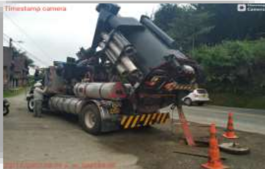
Asistencia técnica con equipos de presión succión.
