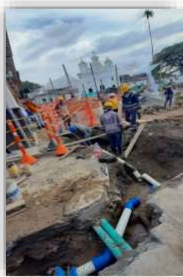
Construcción red de acueducto parque principal
