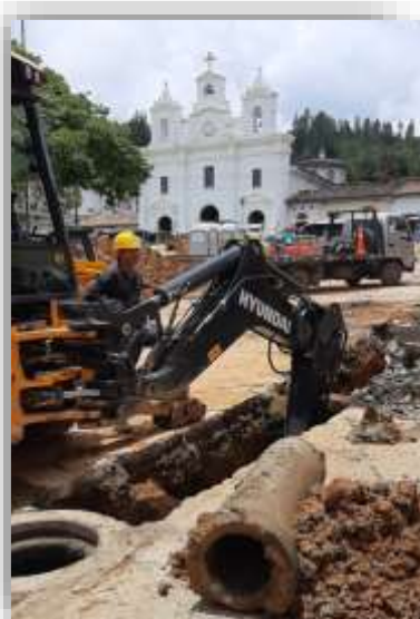
Construcción red de alcantarillado parque principal.
