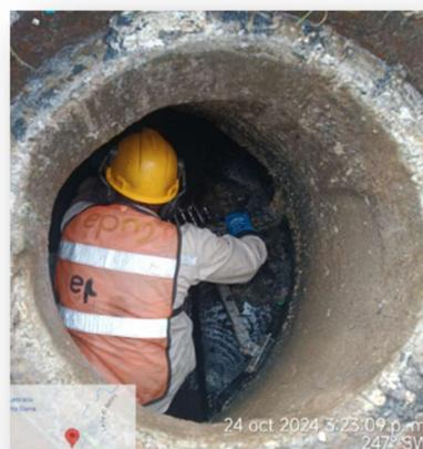
Foto 5: Extracción de trapos y sedimentos
