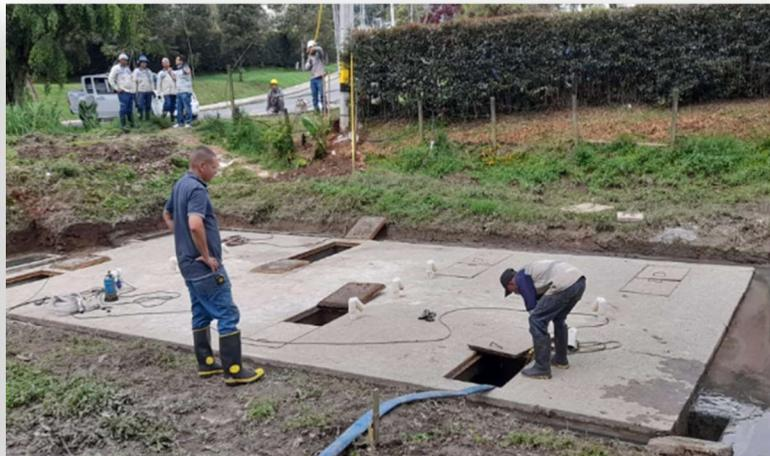
Foto 2: Estracción de sedimentos en pozo N°2
