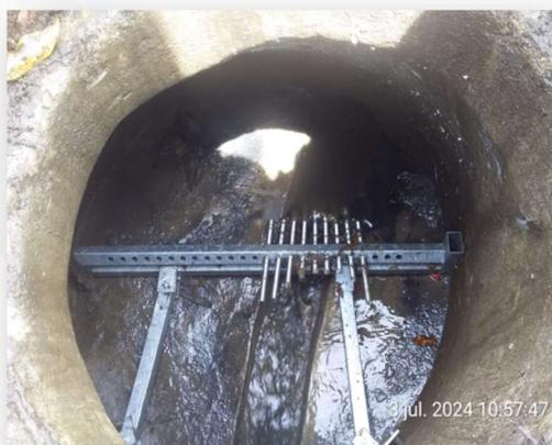
Foto 4: Atrapa trapos en manhole antes de EBAR
