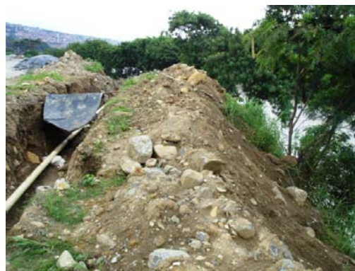
K3+350. Empalme del futuro colector quebrada Santa Rita.
