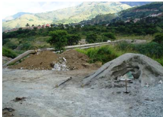
K6+170 Empalme futuro colector quebrada la García.
