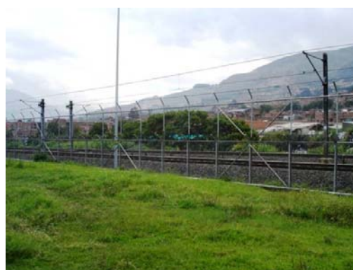
K2+740. Empalme futuro colector quebrada Cañada Negra.
