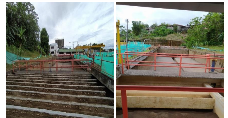
Iniciaron las intervenciones de optimización de la Planta de Tratamiento Playita I
