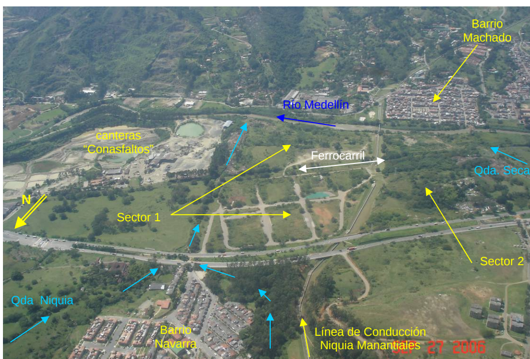
Figura 2.1. Lote para la Planta de Tratamiento de Aguas Residuales Bello
