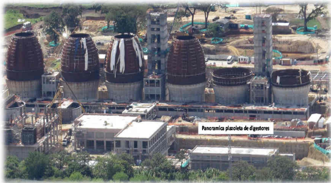
Avance en obras de digestores
