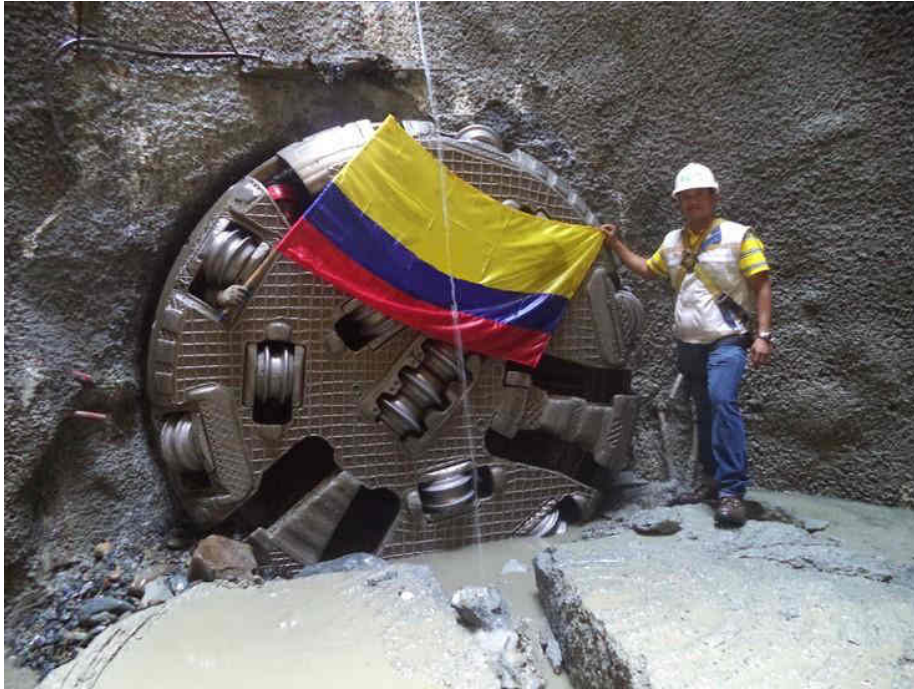
Salida tuneladora “Diana” en pozo C9
