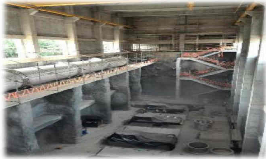
Edificio bombeo de entrada
