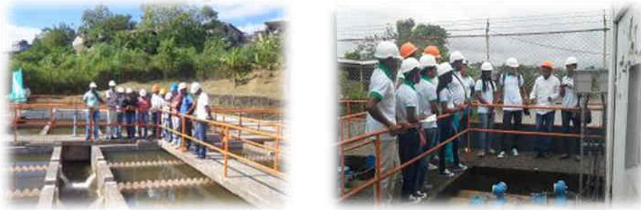
Visitas guiadas a las plantas de potabilización del agua
