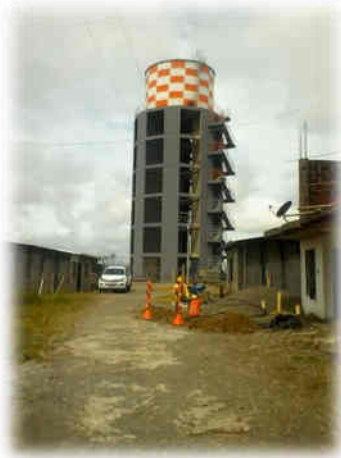
Tanque Zona Minera
