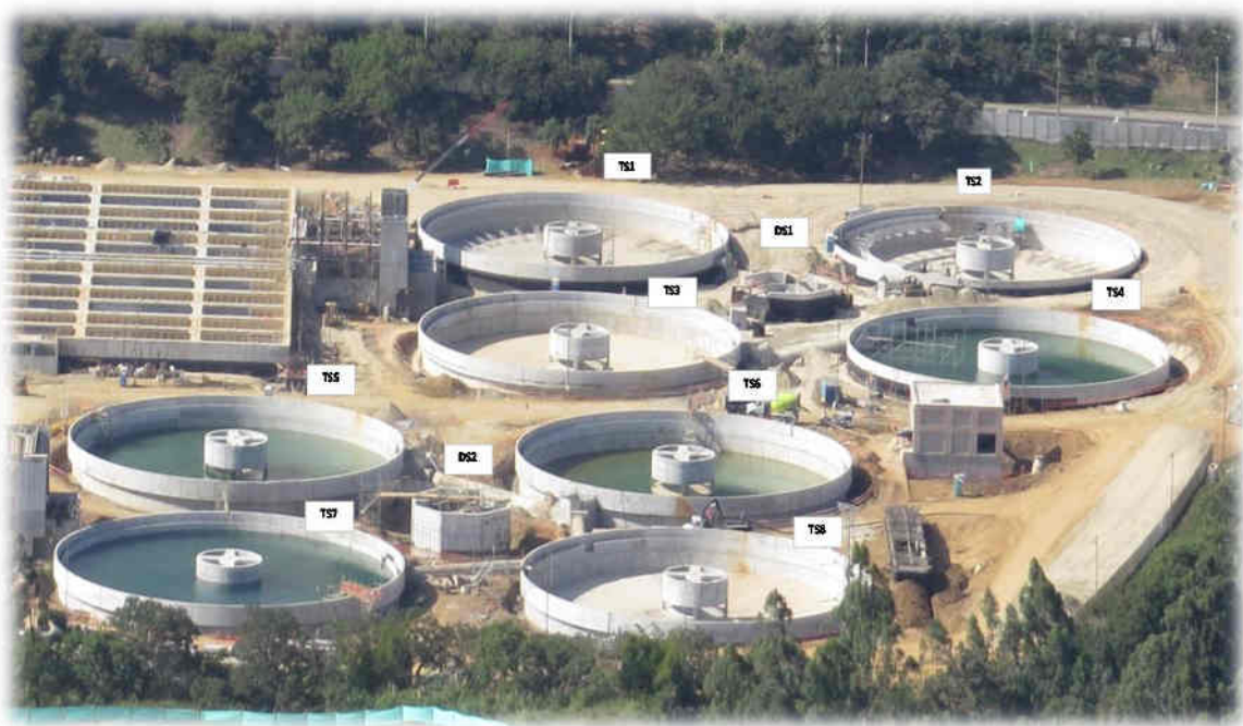
Tanques de sedimentación secundaria
