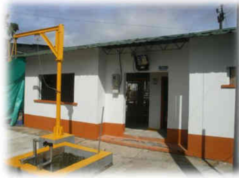
Aspecto actual estación de bombeo
