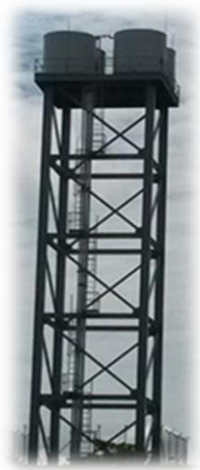
Fotografía 8.23 Tanques de almacenamiento Ciudadela Mia.
