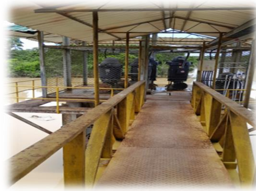
Fotografía 8.4 Estado de Plataforma y Bombas 2025.
