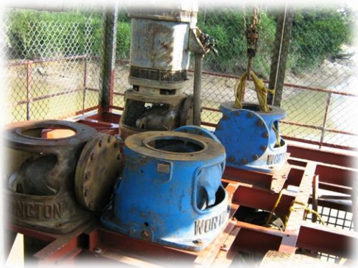
Fotografía 8.3 Estado de Plataforma y Bombas 2008.
