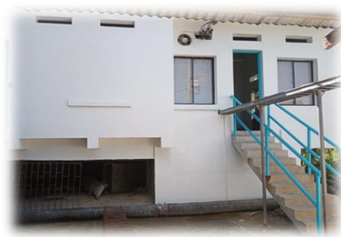
Fotografía 8.16 EBAR La Bombita.
