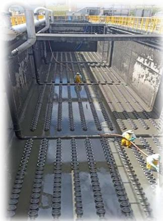
*Figura 11. Mantenimiento de difusores tanque de aireación*
