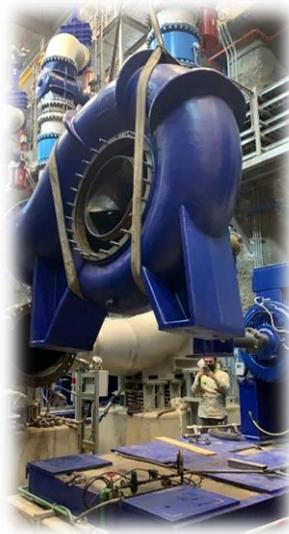
*Figura 14. Mantenimiento bomba de entrada 3*
