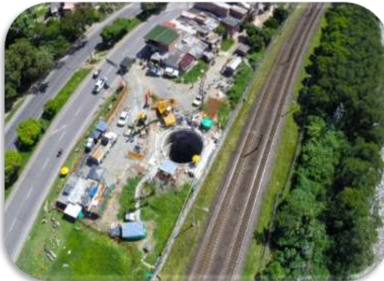
PANORAMICA INTERCEPTOR NORTE
