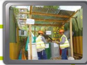
Control y orden a los residuos
