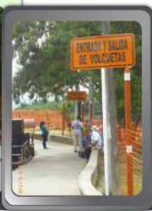
Señalización en obra
