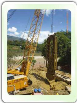
Procedimiento de la Almeja perforando uno de los pozos
