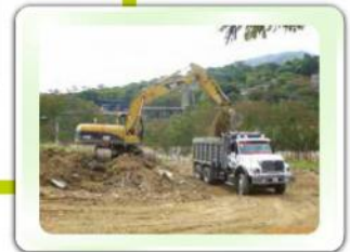
Retiro del material de excavación a depósitos autorizados.
