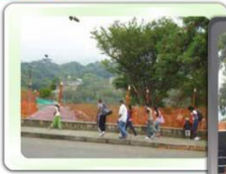
Cerramiento en frente de trabajo
