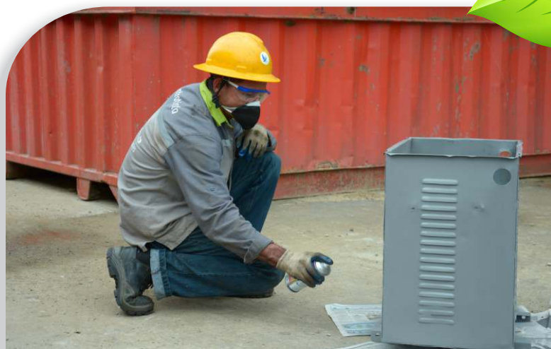
El personal con las medidas de seguridad en el trabajo
