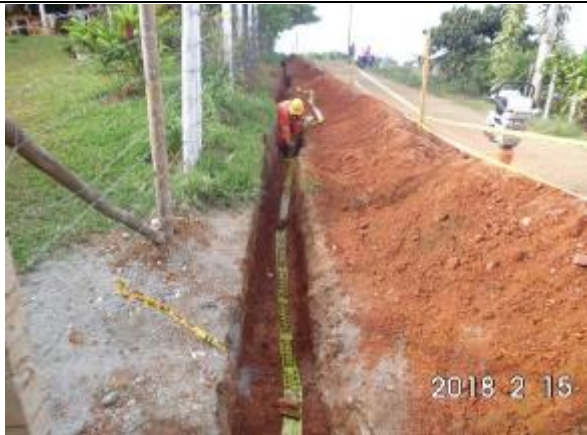
Foto 3: Instalación tubería acueducto
