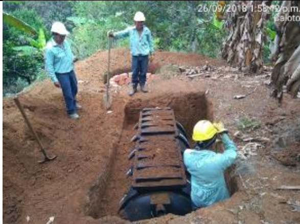
Foto 6: Instalación sistema séptico
