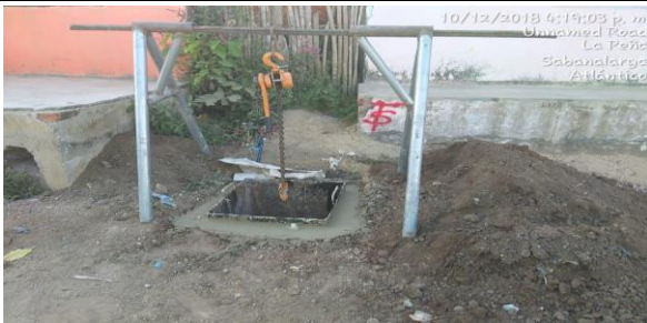
Foto 5: Construcción cajilla domiciliar
