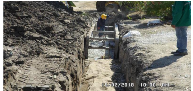
Foto 4: Excavación - instalación de tubería
