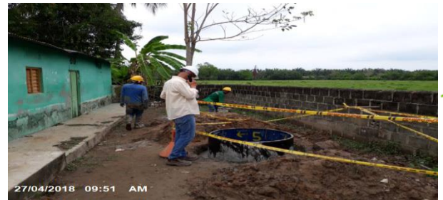
Foto 6: Construcción de MH
