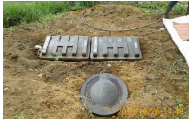
Foto 6: Instalación de Sistema séptico
