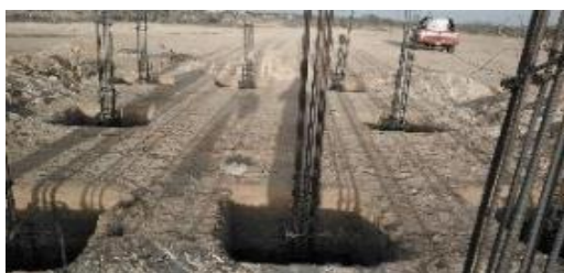
Foto 1: Figuración zapatas y columnas de -Pila pública
