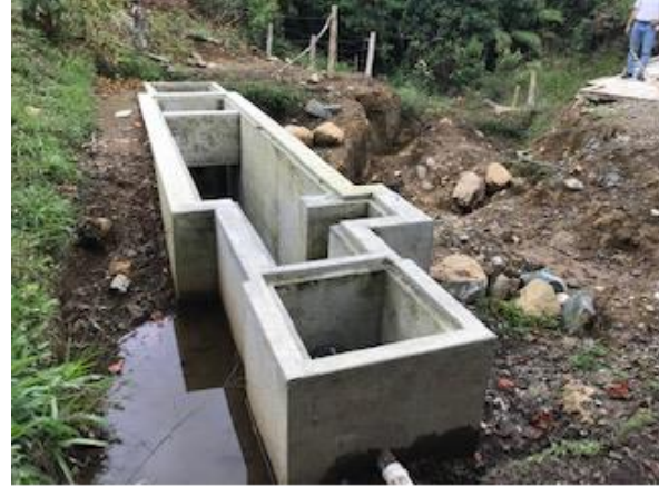
Foto 2: Construcción desarenador
