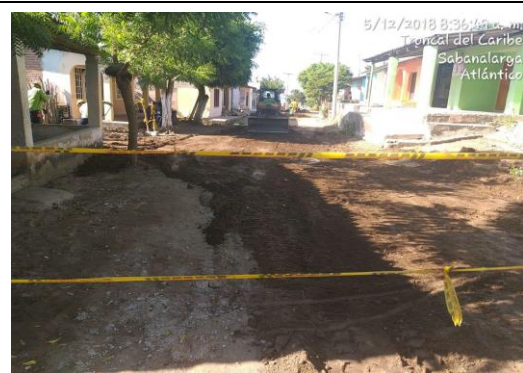
Foto 8: Reparación vías intervenidas
