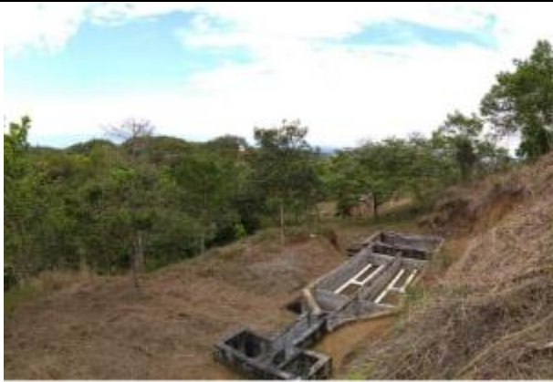
Foto 1: Adecuación filtro Dinámico
