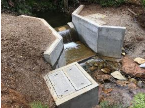
Foto 1: Construcción bocatoma
