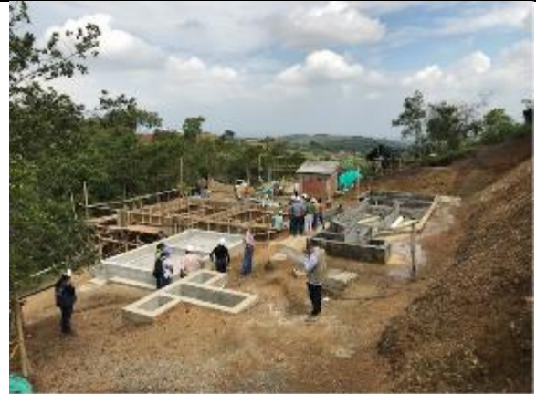
Foto 2: Construcción planta de potabilización
