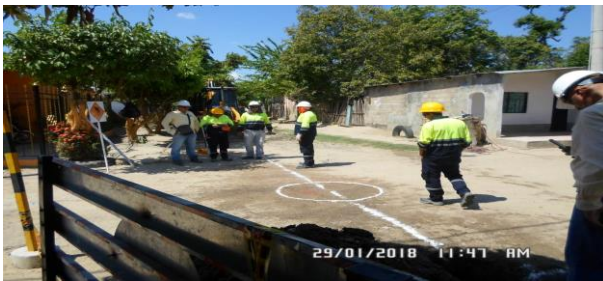
Foto 3: Demarcación eje tubería
