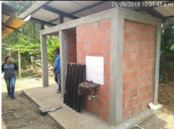
Foto 5: Construcción Unidad sanitaria
