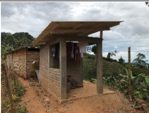
Foto 5: Construcción unidad sanitaria
