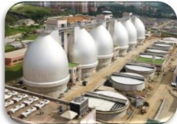
Tanques digestores
