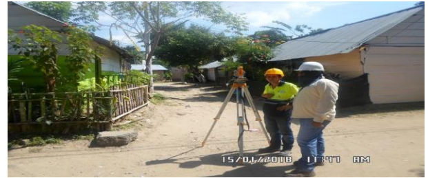
Foto 2: Replanteo topográfico de redes
