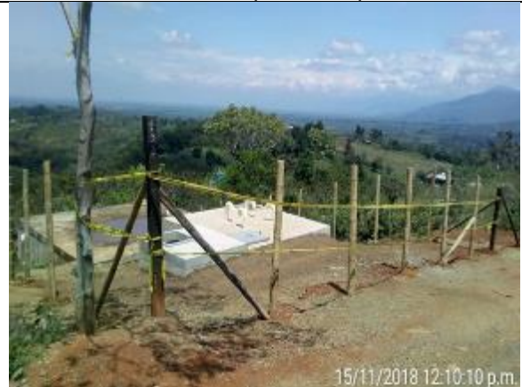
Foto 4: Construcción tanque almacenamiento
