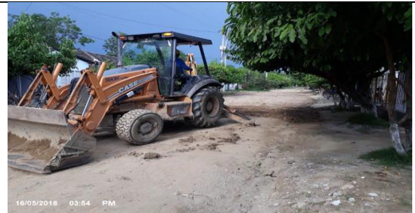
Foto 8: Arreglo de vías
