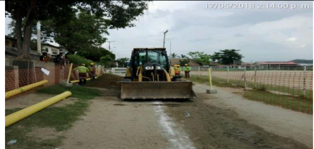
Foto 2: Demarcación de eje de excavación
