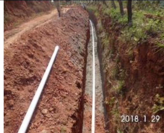
Foto 4: Instalación tubería acueducto
