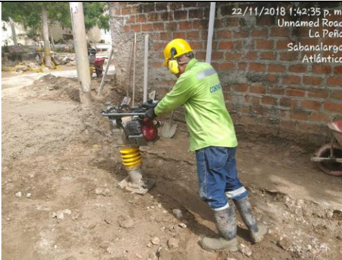
Foto 7: Reparación sectores intervenidos
