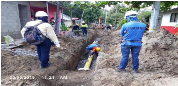
Foto 5: Construcción de domiciliar
