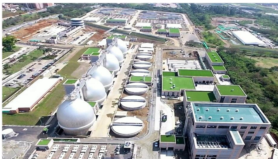
Panoramica PTAR Aguas Claras
