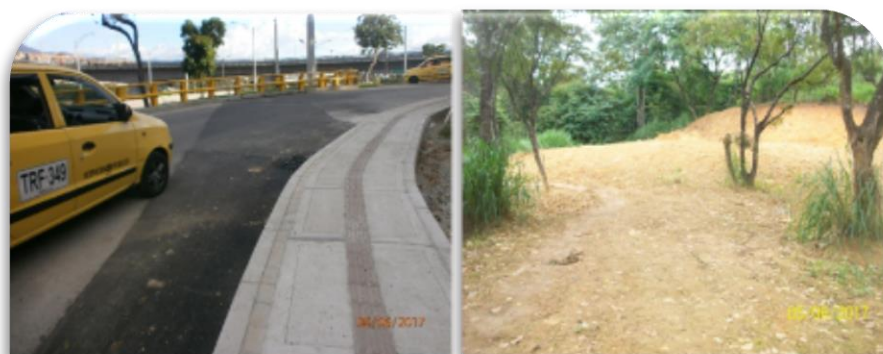
Pavimentación de vías y adecuación de zonas de trabajo RAMALES COLECTORES
