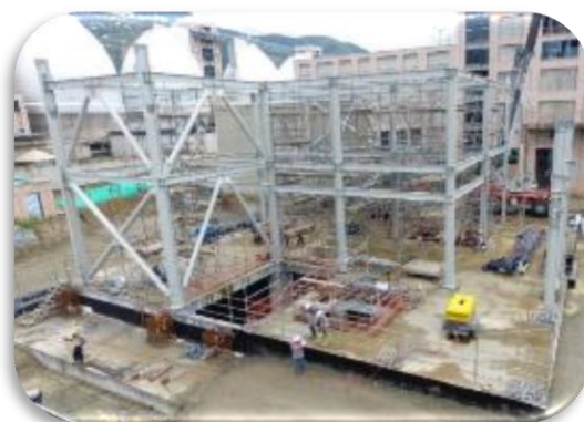
Avance de obra
