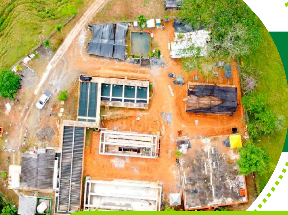
Foto aérea del proceso constructivo de la ampliación de la PPAP
