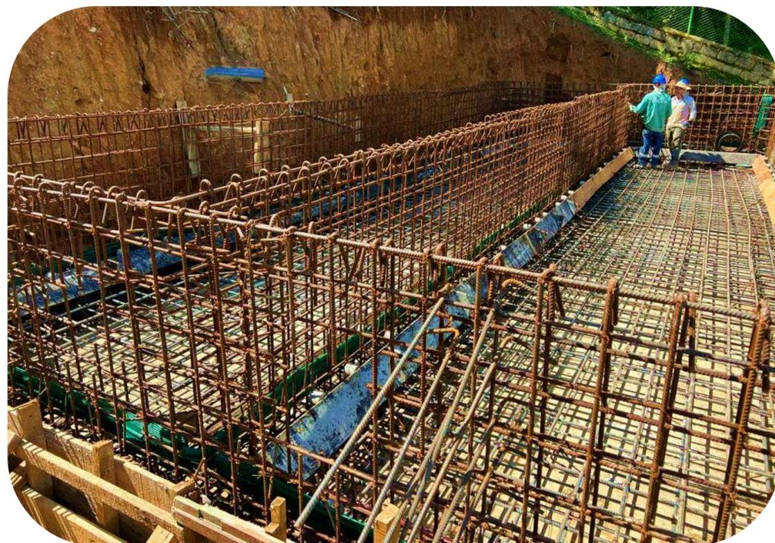
A la fecha, hemos finalizado las actividades de excavación, construcción de solado de limpieza, figuración y colocación de acero de refuerzo para las estructuras de floculación y el canal de aforo.
