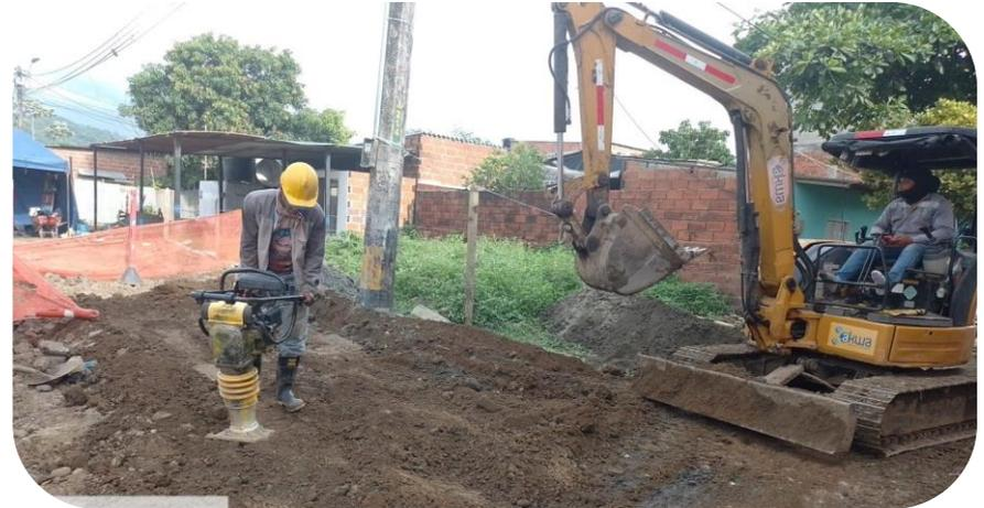
En el marco de este proyecto, luego de que la administración municipal habilitara las vías para la instalación de redes de acueducto, se llevó a cabo la instalación de 1.194,30 metros de tubería polietileno de 90 milímetros, cumpliendo con todas las especificaciones técnicas para garantizar la calidad y continuidad del agua potable.
