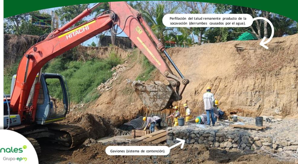
Perfilación del talud remanente producto de la socavación (derrumbes causados por el agua).
