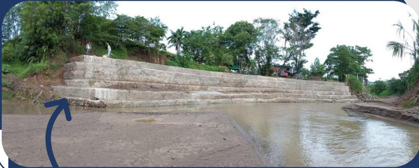
La protección del talud se realiza mediante unos gaviones (sistema de contención), consistentes en una caja de forma prismática rectangular, rellena de piedra.
