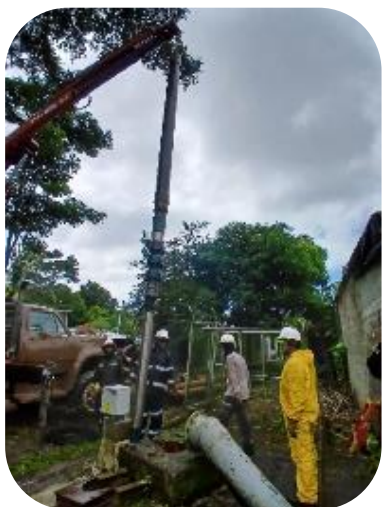
Actividades de mantenimiento a pozos profundos
