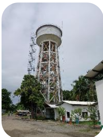
Gestión para el suministro e instalación de acceso certificado al tanque elevado sede operativa Apartadó
