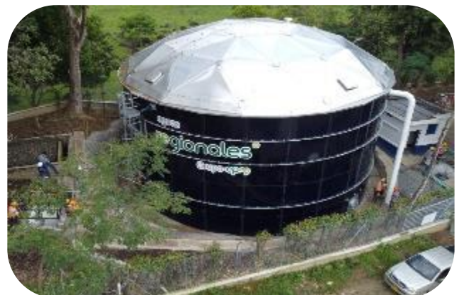
Instalación domo y láminas del tanque
