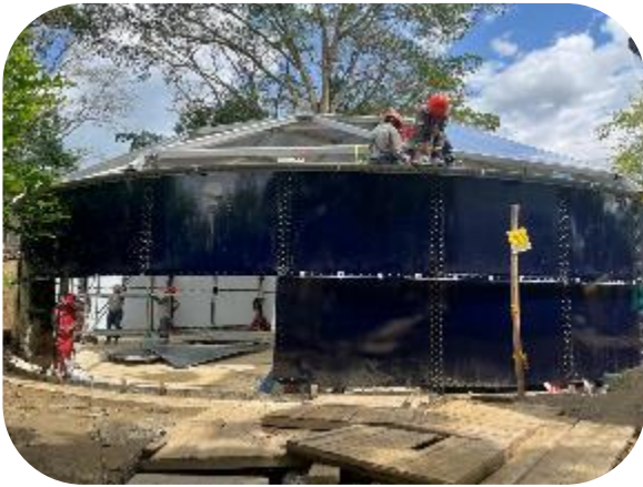
Instalación domo y láminas del tanque
