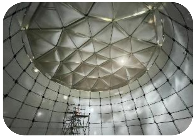
Instalación domo y láminas del tanque
