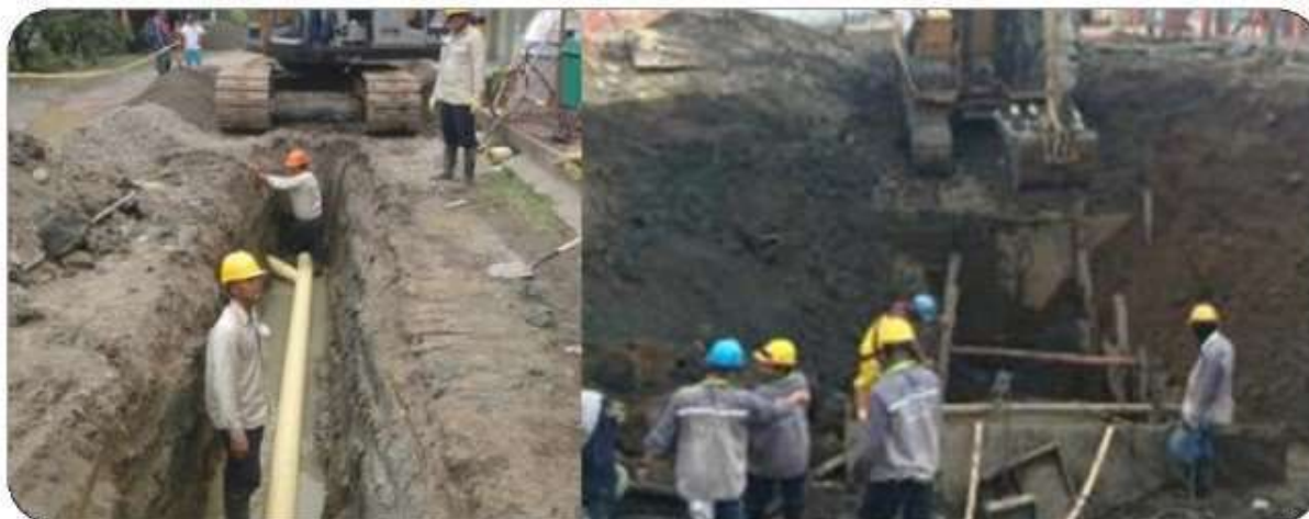
Imagen 17. Construcción de colector Bohío Etapa II (2,2 Km)
