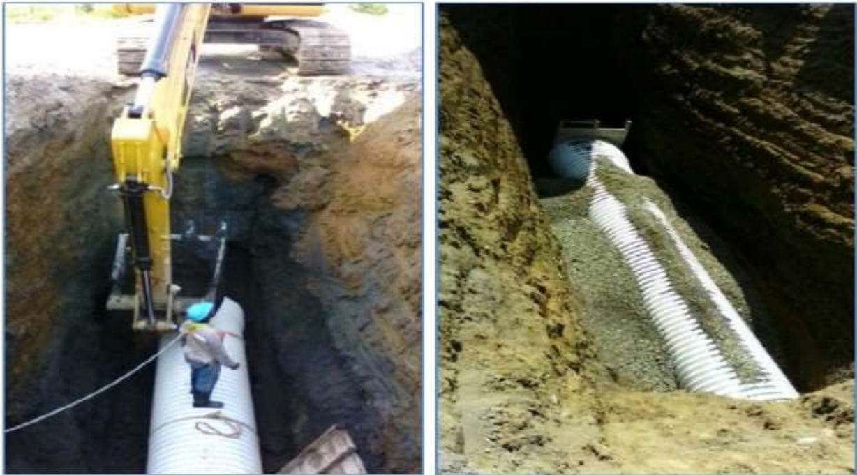
Imagen 16. Construcción de colector Etapa II (1,42 Km)
