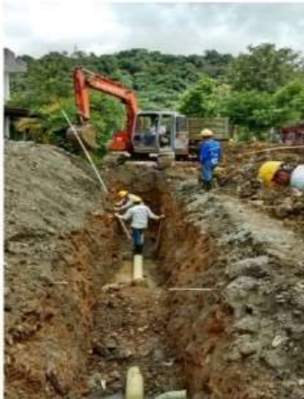
Extensión redes Acueducto
