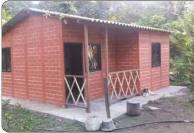
CONSTRUCCIÓN DE CASETA BOCATOMA APARTADÓ
