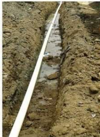
extensión redes alcantarillado
