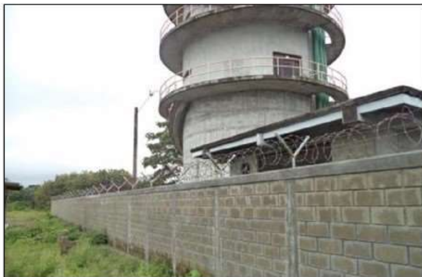
Cerramiento en muro tanque El Paraíso
