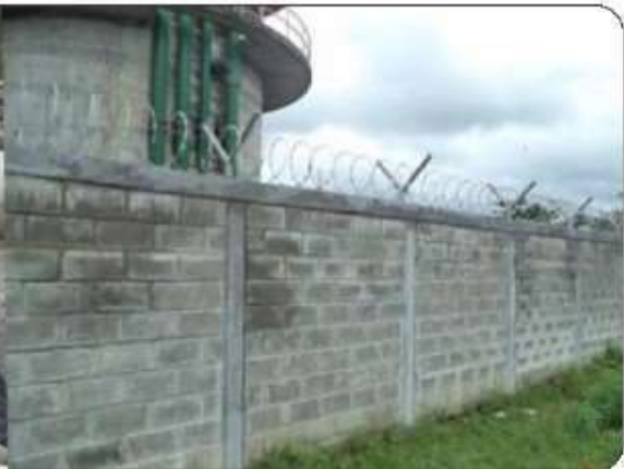
CERRAMIENTO TANQUE 20 DE ENERO
