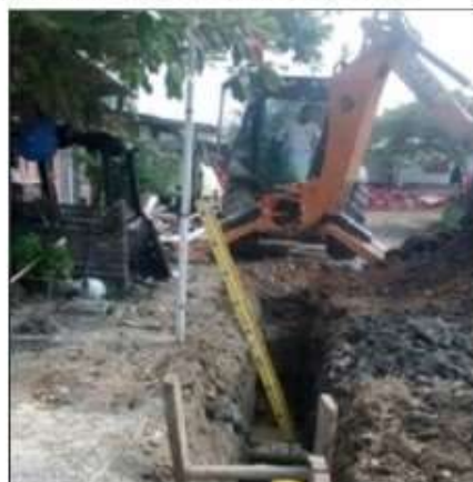
Imagen 14. Optimización y/o extensión de redes de recolección de alcantarillado
