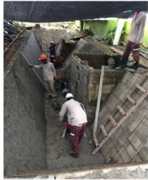
Imagen 21. Construcción de Desarenador
