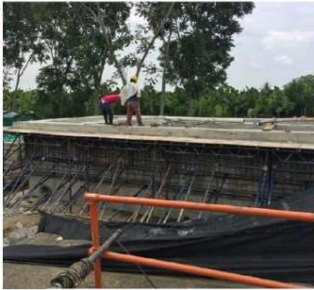
Imagen 21. Construcción de Desarenador
