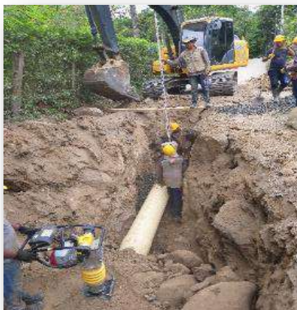
Instalación de tubería Colector El Rodeo
