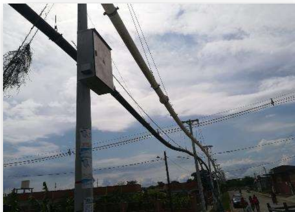
Construcción Red aérea
