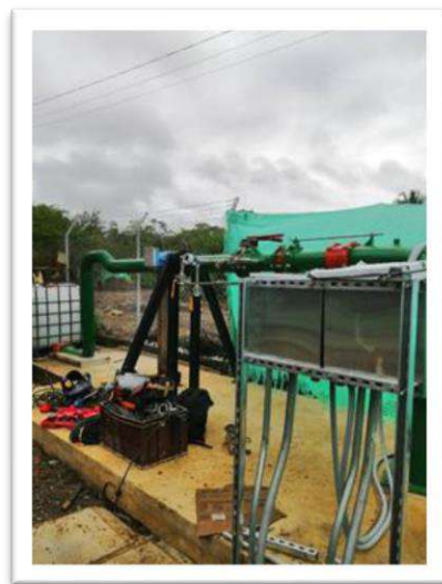
Pozo construido en la planta El Reposo
