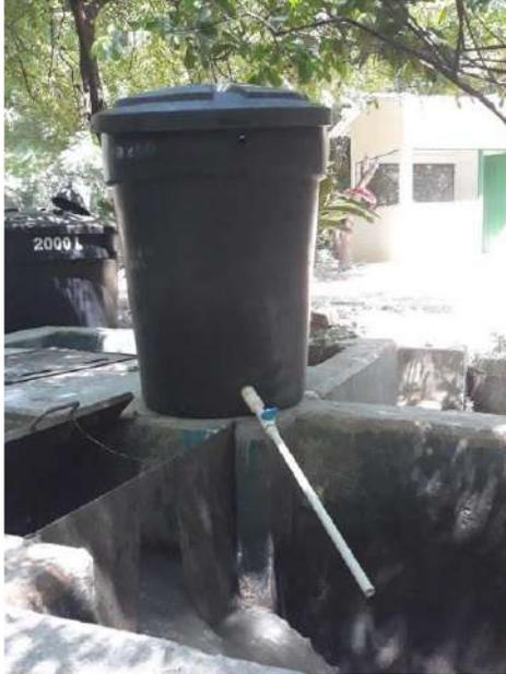
Aplicación por goteo en la PTAR de Santa Fe de Antioquia
