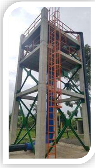
Torre aireación pozo Turbo
