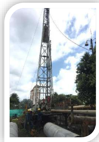
Construcción pozo profundo en el municipio de Apartadó
