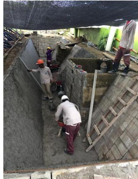
Imagen 20.Construcción de Desarenador
