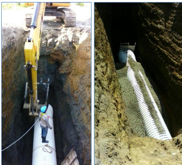
Imagen 15. Construcción de colector Etapa II (1,42 Km)
