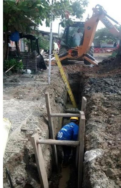
**Imagen 13. Optimización y/o extensión de redes de recolección de alcantarillado**
