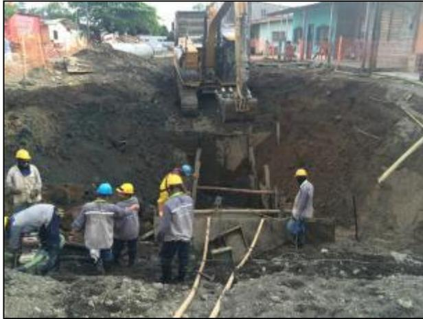
Imagen 16. Construcción de colector Bohío Etapa II (2,2 Km)
