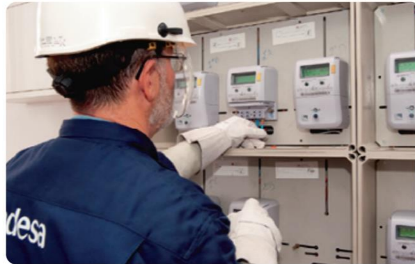
Ilustración 13. Instalación de contadores por un operario de Endesa en el Proyecto Smartcity Málaga. Fuente: (ENDESA, 2016)
