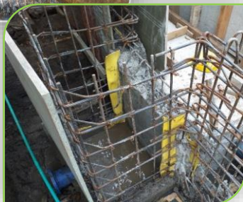
Instalación de cinta de PVC en las estructuras de canal de entrada y sedimentador
