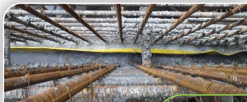
Instalación de cinta de PVC en las estructuras de canal de entrada y sedimentador
