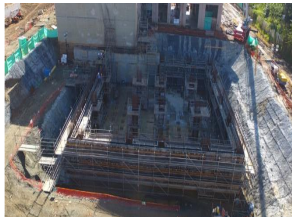
Preparación para vaciado de concreto en muro perimetral y columnas externas.
