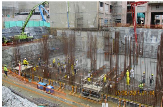
Vaciado de concreto en losa de cimentación.
