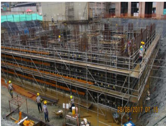
Instalación de encofrado en muro perimetral y columnas externas.
